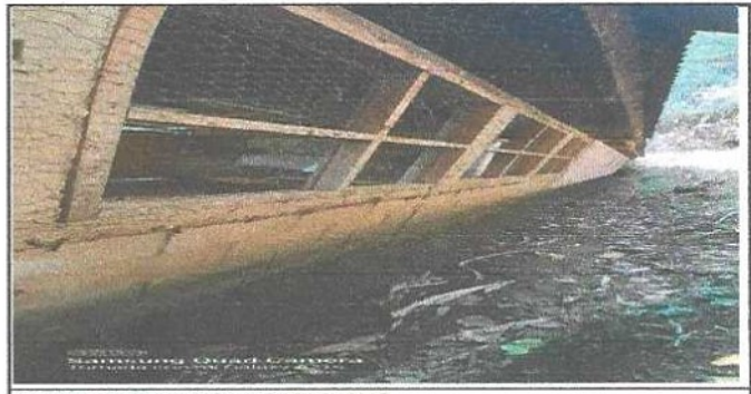
FOTO 6: SUSTITUCION DE VENTANAS
