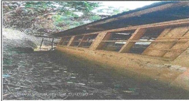
FOTO 1: REPARACION DE COCINA
