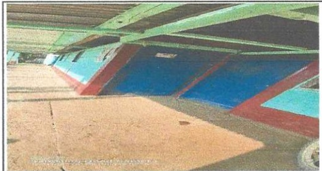
FOTO 3; SUSTITUCION DE ENTECHADO
