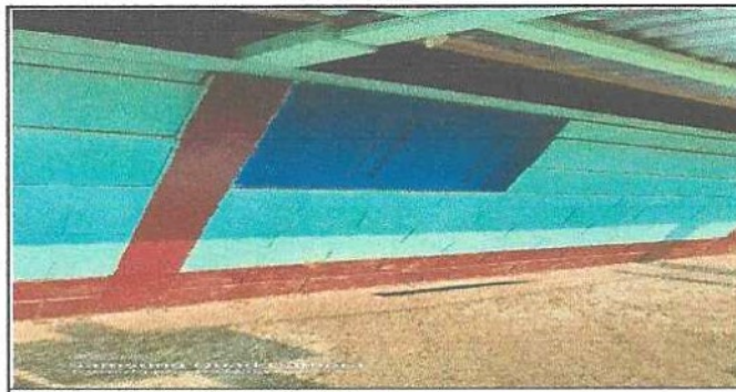
FOTO 5: SUSTITUCION DE VENTANAS
