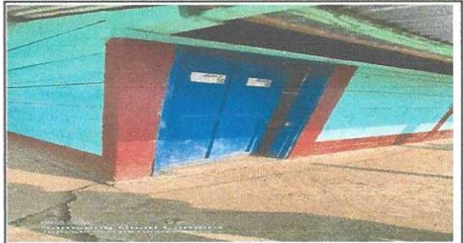
FOTO 4: SUSTITUCION DE PUERTAS
